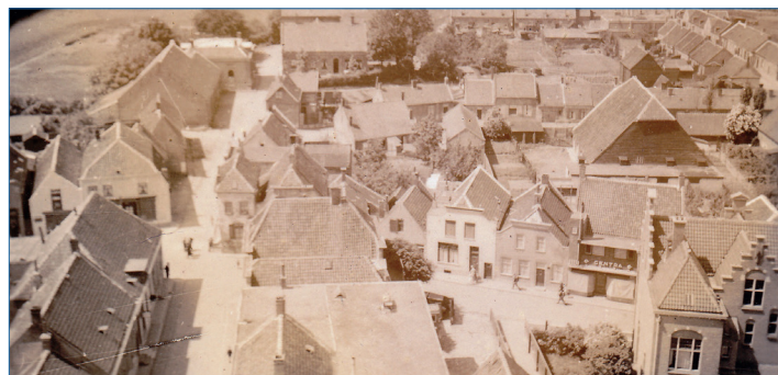
foto genomen vanaf de toren van de katholieke kerk. Oliemolenstraat, de Kaai en Voorstraat, 1935
