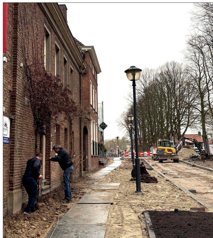
Foto Evy de Visser-Strootman: Zaterdag trof Evy in de Molenstraat John Schuurmans en Ed de Roos aan. Zij zijn op eigen initiatief, ondersteund door de KOK, bezig met het vernieuwen van de kabels in het centrum. Dit zodat het geluidssysteem in het centrum weer optimaal werkt. Een prachtig voorbeeld van zelf de handen uit de mouwen steken voor een fijn, leefbaar centrum.
